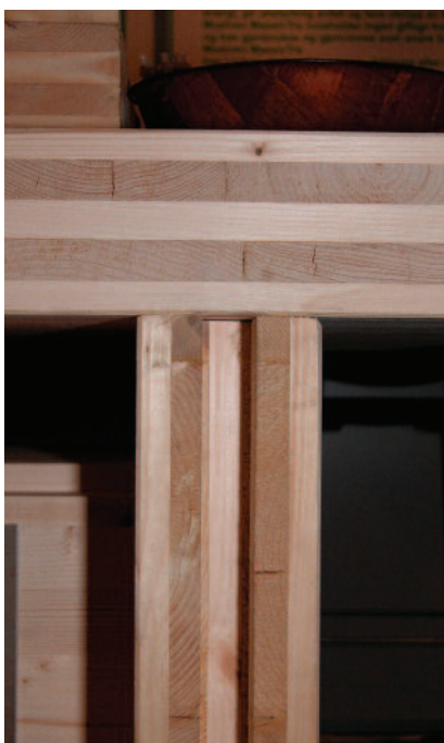
Vegg og etasjeskillere i massivtre.
