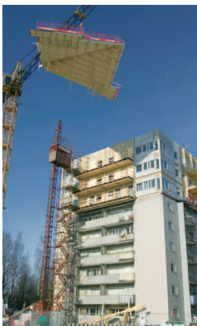
Et 6-etasjes hus får 3 nye etasjer i tre. Plogen, Umeå, Sverige.
