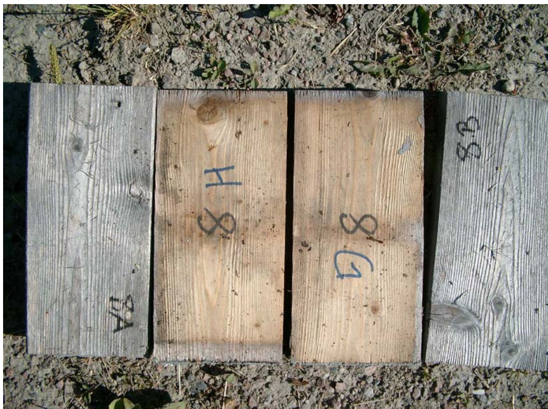
Figur 168. Lerk, kjerneved, ingen overflatebehandling.
