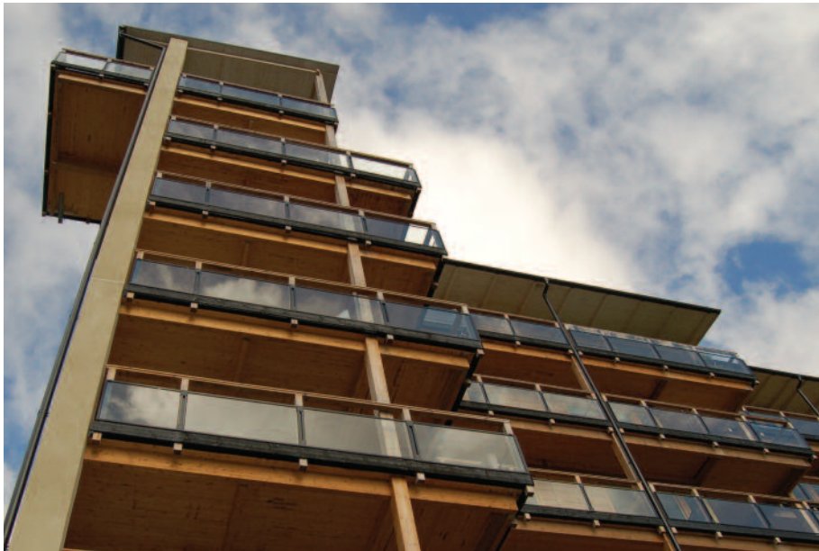
Limnologen er et annet eksempel på fleretasjes trebygg basert på trekonstruksjoner. Her er det også benyttet tre som fasademateriale.
