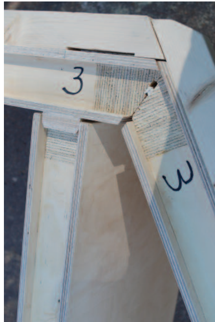
Loft/tak/vegg-sammenføyning. Her ser dere både not- og fjærsammenføyningen og 60 graders-profilene som presses sammen av nylonbåndene.
