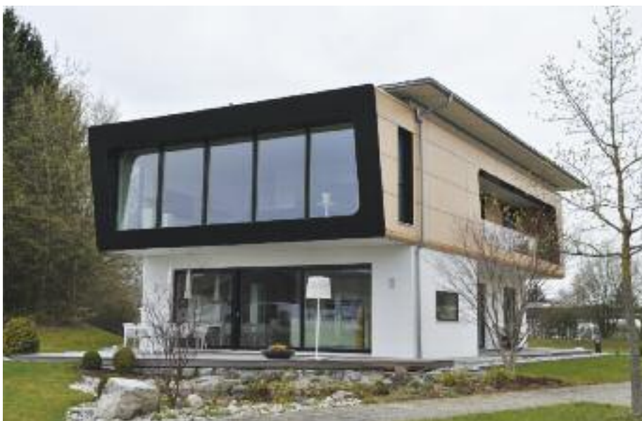
Regnauer Fertigung lager også trehus med tak med skjult helling og platekledning.
