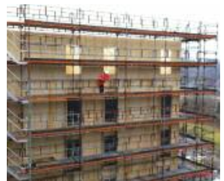
Råbygg i massivtre.
