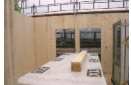
Baderomsmoduler, materialer og vinduer heises inn samtidig med elementmontasje.
