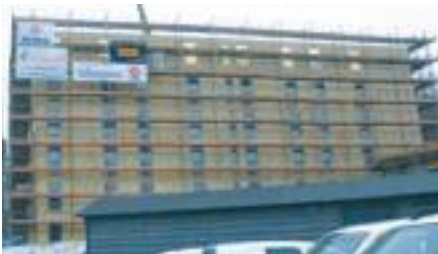
Blokker i massivtre på Remmen i Halden.
