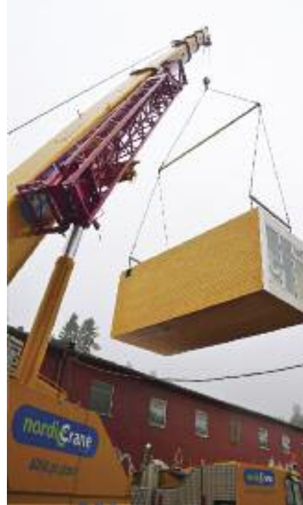
Passivhusmodulen løftes for transport.
