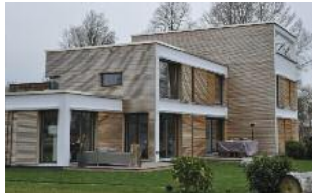
Ubehandlet kledning sprer seg utover Europa.
