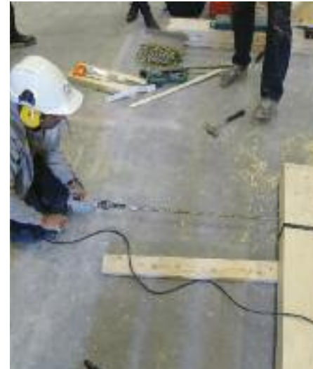
800 mm lange skruer i rammehjørner.
