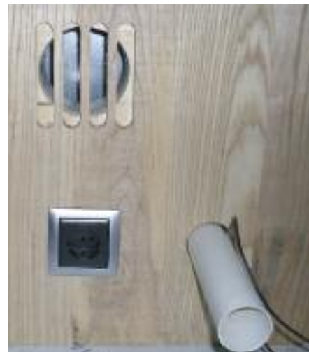
Massivtrelementer med ask overflate. Utfresinger for tekniske installasjoner.
