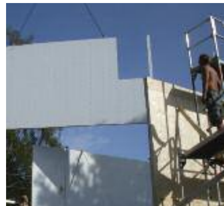
Montasje av store veggelementer.
