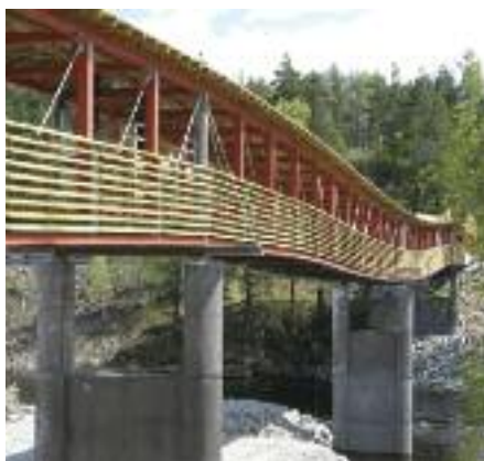
"Bølgen", fagverksbro over Numedalslågen ved Kongsberg.
