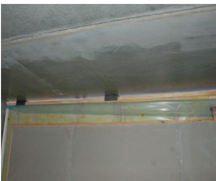
På innsiden blir overgang mot gulv, tak og betongvegger, et ca. 30 cm bredt felt isolert og kledd med gips.
