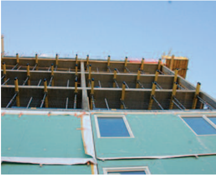
Montasje av prefabrikerte ytterveggselementer
