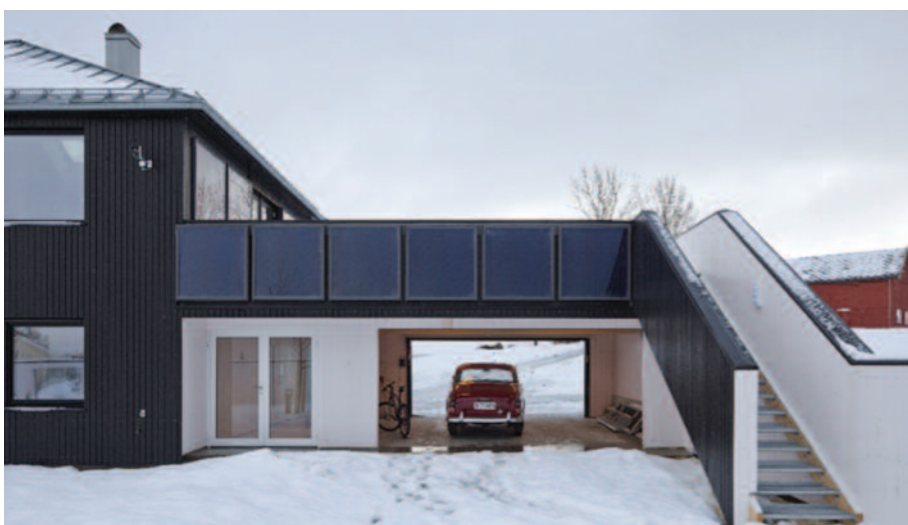
Figur 7: Aktivhus i Stjørdal er et av casestudiene på trekonstruksjoner i KlimaTre. Det er et samarbeid mellom SINTEF Byggeforsk og NTNU, hvor Agneta Ghose skal gjøre en livsløpsvurdering av huset i sitt masteroppgavearbeid. Arkitekt: Brendeland & Kristoffersen arkitekter AS og byggherre: Framtidens Aktivhus AS (Foto: Torben Eskerod).
