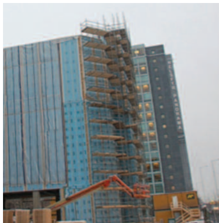
Utskifting av fasader på Skatt Øst på Helsfyr i Oslo.
