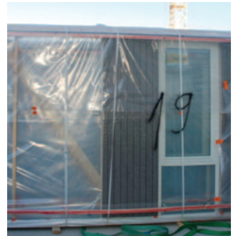
Innpakkede elementer på byggeplassen, klar for montering.
