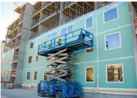
Ferdigstillelse av skjøter.
