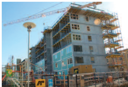
Fra byggeplass mars 2012. Montasje av ytterveggselementer Blokk A.
